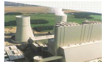
Kraftwerk Schwarze Pumpe
