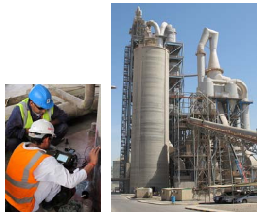
Reperatur und Prüfung von Ermüdungsrissen
